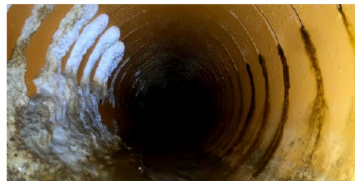
Abbildung 1: Versinterungen im Drainagerohr
